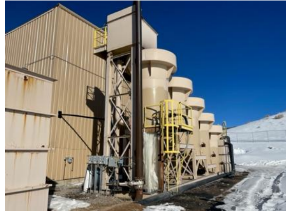
ADR Exterior Columns
