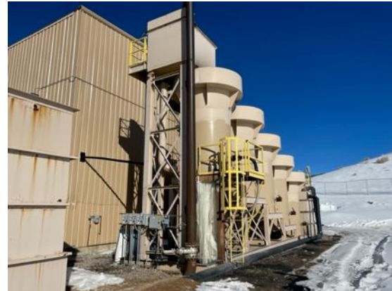
ADR Exterior Columns
