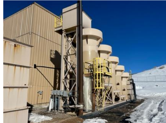
ADR Exterior Columns
